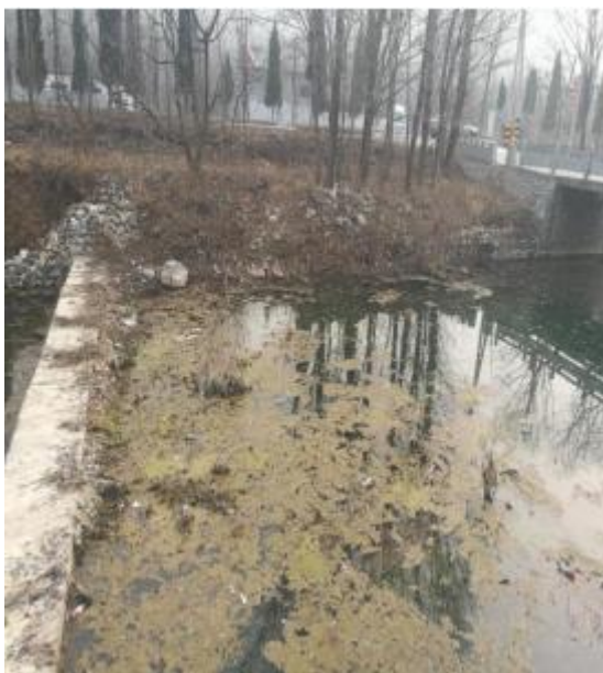
河道右岸、紧靠交通桥处挡墙坍塌
